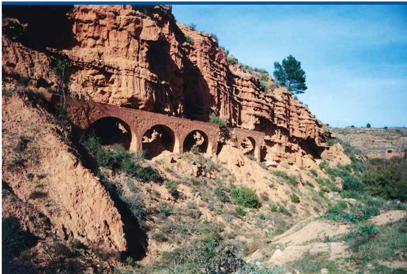
Acueducto de la Balsa de Torrealta (Ademuz)
