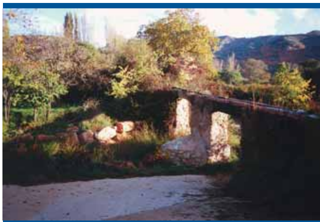
Acueducto del Barranco de la Clareta (Castielfabib)
